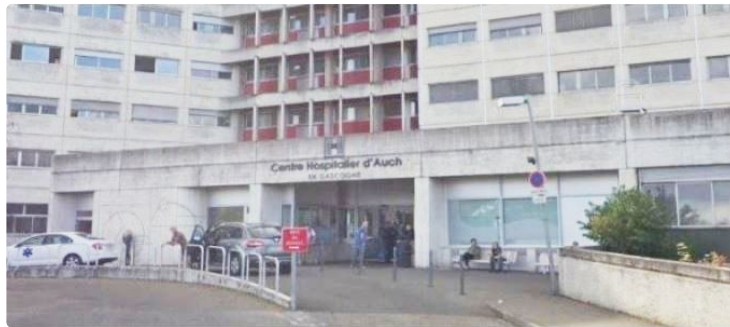
Centre hospitalier d'Auch, ce sera une rénovation-extension de l'hôpital sur son site actuel qui est privilégié.
